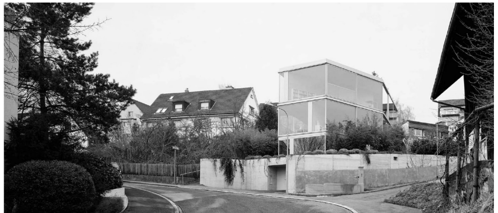
Christian Kerez, Maison avec un mur, Zurich, 2004-2007, vue depuis la Eierbrechtstrasse
